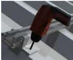
Abbildung 100 Klemme verbohren
